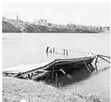
Пирс на пляже сильно поврежден во время ледохода
